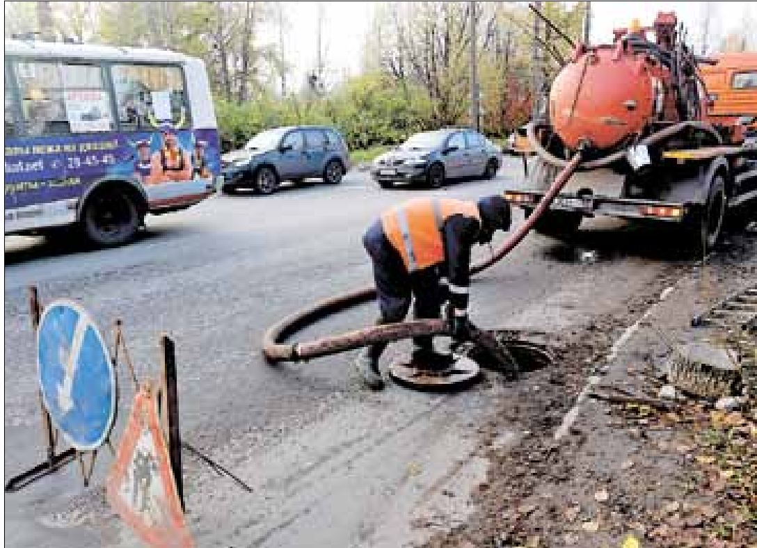
■ Ремонтные работы на пересечении ул. Гагарина и пр. Обводный канал
