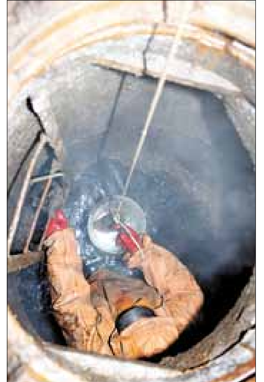
■ Опасный спуск в коллектор
